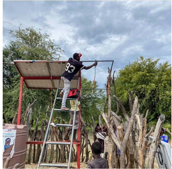
Abbildung 5: Mudio und die lokale Gemeinschaft installieren Solarplatten in Shaditata
